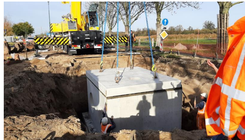
Plaatsing overstortput HWA
