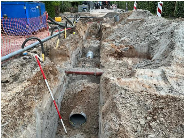
Aanleg gescheiden riolering Leusden-Zuid
