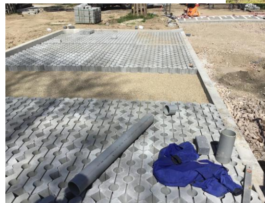
Aanleg waterdoorlatende parkeerverharding
