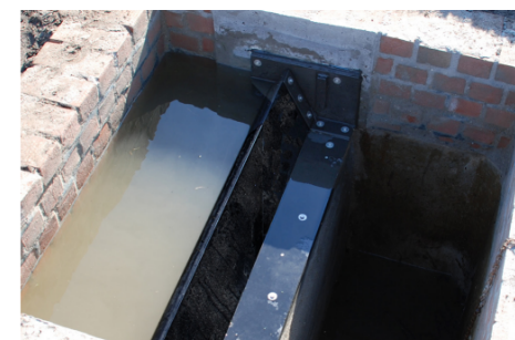
Figuur 8 Foto zelfrichtende overstortdrempel
